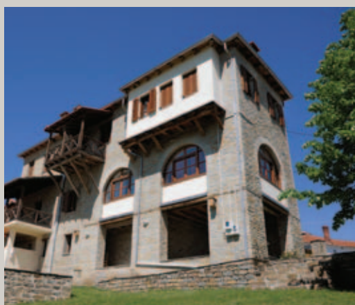
Εξοχική κατοικία, εξωτερική όψη.
